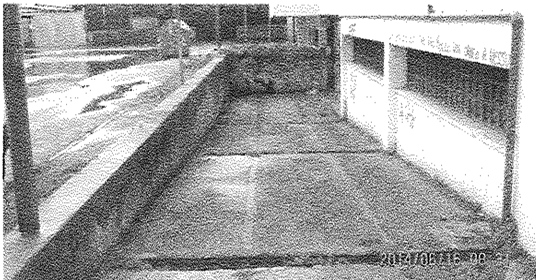
Rampa di accesso secondaria al seminterrato
